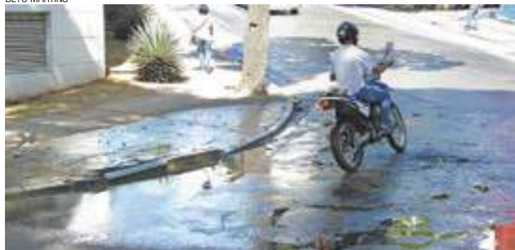
Esgoto - Água suja invade a calçada e o meio-fio no cruzamento de duas ruas
