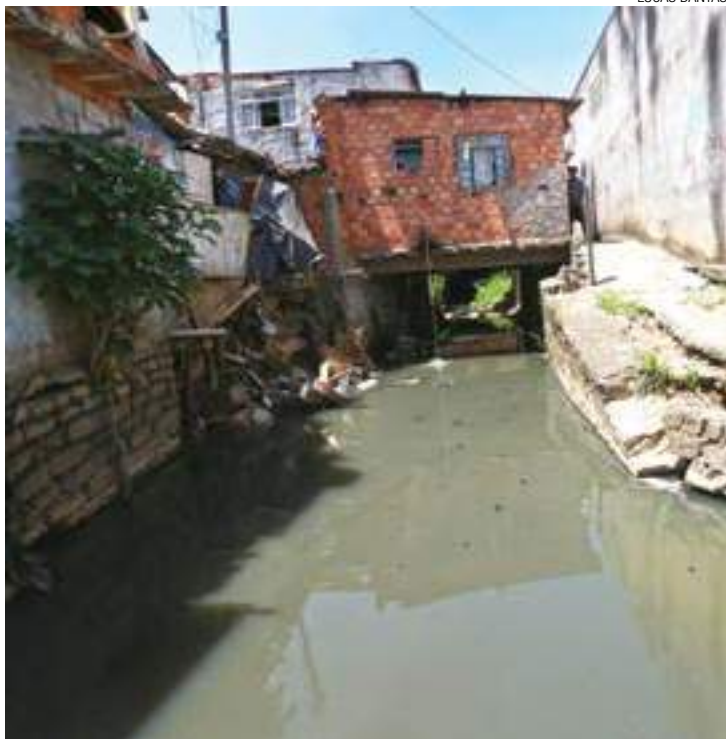
Cena comum - Esgoto de residência cai direto em córrego na cidade
