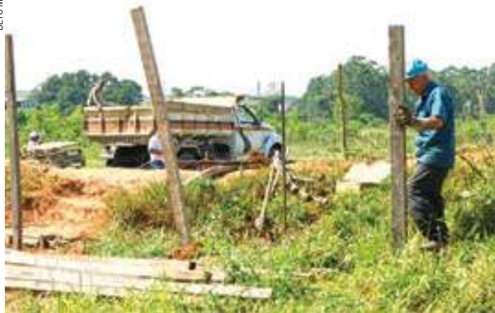
Proteção - Funcionários da Proguaru colocaram cercas no terreno ontem
