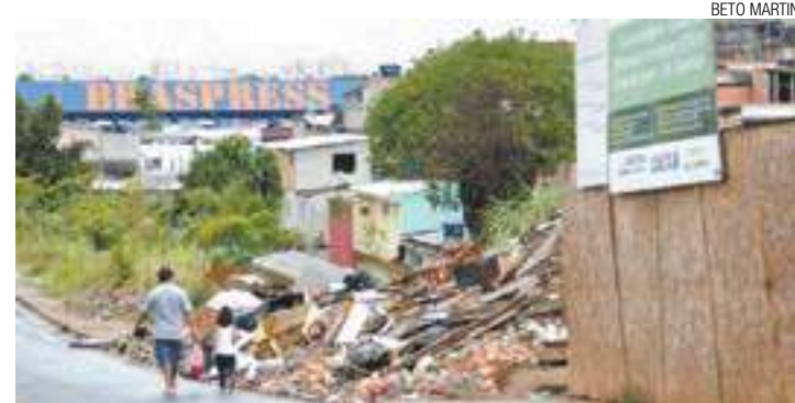
Abandono - População reclama de obra não iniciada há três anos
