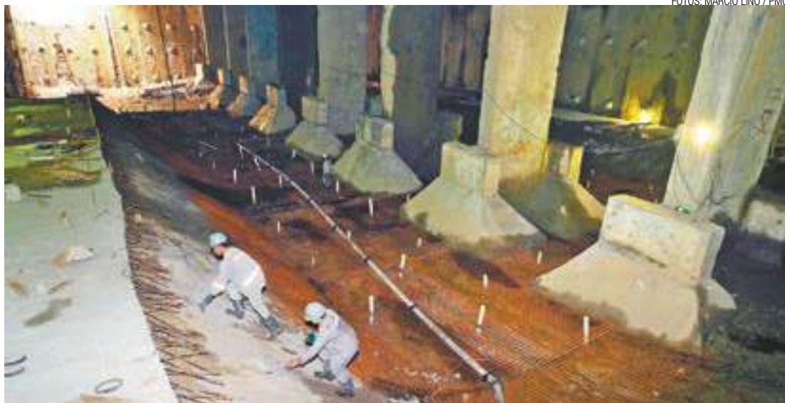
Trabalho - Concretagem da laje de fundo do reservatório do Córrego Jacinto foi feita na quarta
