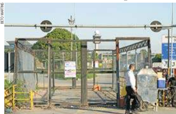
Proibido - Ponte foi fechada para obras em 2013 e nunca mais foi reaberta
