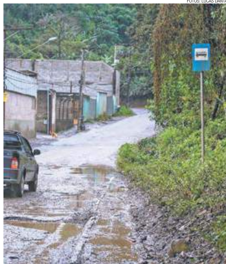
Abandonado - Parada de coletivos fica em calçada tomada por matos
