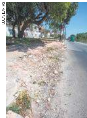
Feio - Calçadas incomodam os moradores do Jardim Fátima
